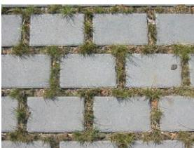
**Rasenfugenpflaster** ohne Fugenverguss. Mit Rasenfugenpflaster kann ca. 20 bis 30 % der Gesamtfläche begrünt werden. Mit einer Mindestfugenbreite ab 15 mm wird die Fläche mit 60 % Versiegelung berechnet.
