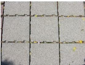
**Betonpflasterstein.** Mit einer Fugenbreite bis 15 mm wird die versiegelte Fläche mit 70 % Versiegelung berechnet.
