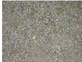
Die Oberfläche besteht aus **Kies oder Splitt** mit einer gleichförmigen mittleren Körnung, der auf einem durchlässigen Unterbau aufgebracht wird. Diese Oberfläche wird mit 50 % als versiegelt berechnet.
