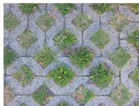
Bei **Rasengittersteinen** wird von dem Boden soviel Wasser aufgenommen, dass von einer Entlastung der Kanalisation von 80 % auszugehen ist, d. h. bei Rasengittersteinen wird die versiegelte Fläche mit 20 % berechnet.
