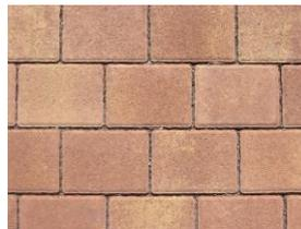
**Wasser- und luftdurchlässiges Betonsteinpflaster.** Bei diesem Porenpflaster wird die Versiegelung mit 40 % berechnet.
